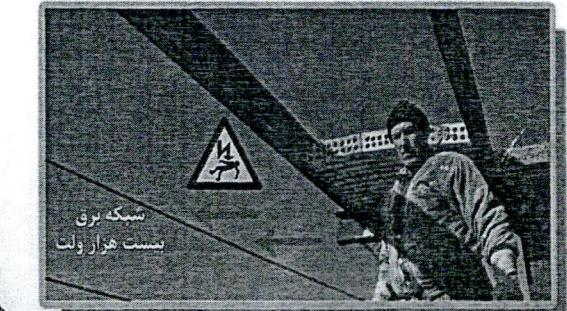
۴- در هنگام استفاده از بالابر جهت حمل و نقل مصالح ساختمانی در مجاورت شبکه‌ها لازم است فاصله بالابر و افراد مشغول بکار مطابق بند ۲ رعایت گردد.
