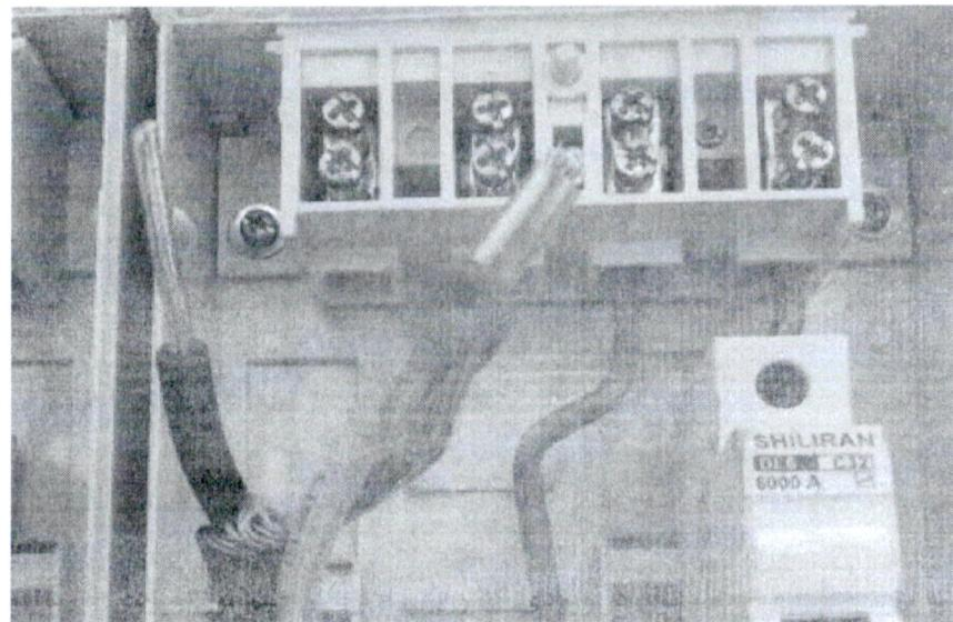
شکل (۴) همبندی سیم ارت مشترک و نول ورودی از شبکه بوسیله واير شو دوبل نمره ۶
